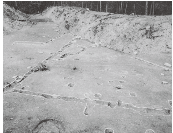
建物等検出状況
